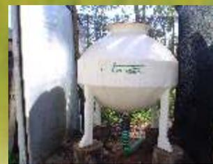
Foto 1. Estanque fermentador con evacuación de agua por el fondo
