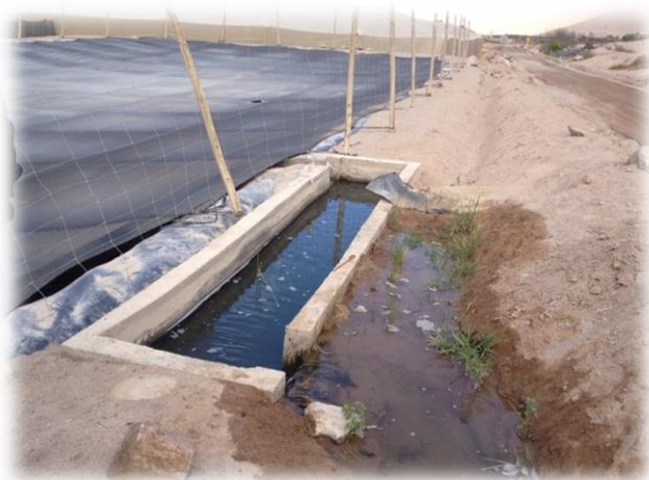
Figura 6. Canal de aducción sin revestimiento.
