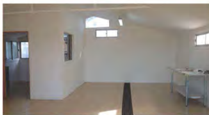
Foto 3: Paredes y pisos lavables.
