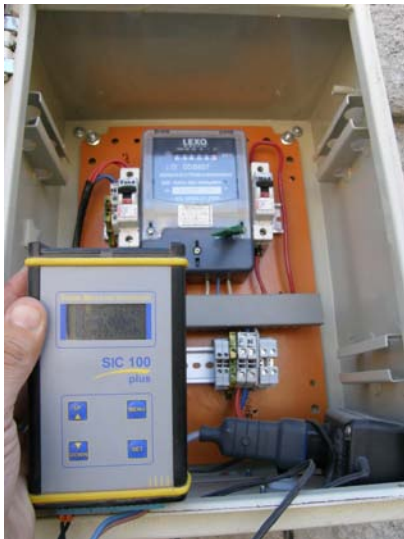
Figura 3. Registro de consumo eléctrico mediante datalogger (km 21 del Valle de Azapa; año 2013). Fuente: INIA Ururi (2016).
