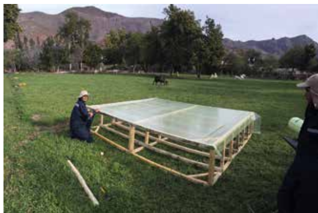
Figura 4. Módulo de producción en proceso de instalación de cobertura de polietileno.
