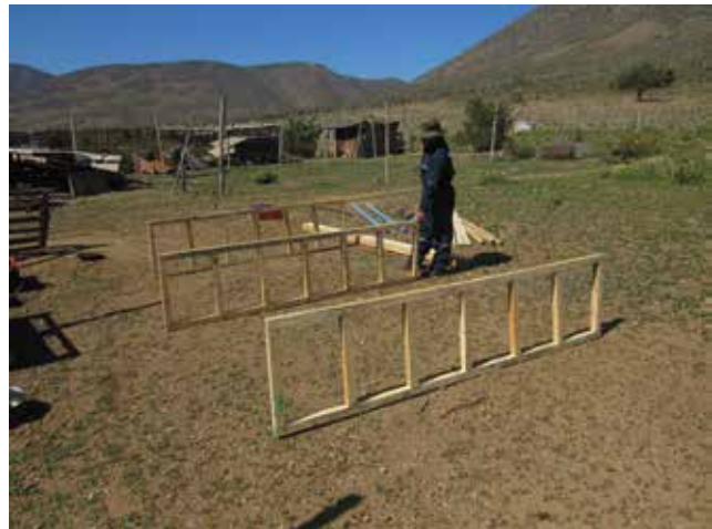
Figura 2. Bastidores armados y dispuestos en terreno para su unión.
