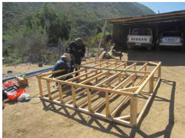
Figura 3. Bastidores unidos y con escuadras instaladas.
