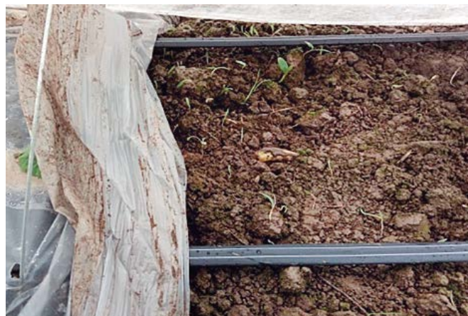
Foto 9. Cintas instaladas sobre la hilera.
