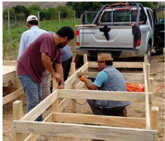
Figura 2. Armado de estructura base del SRF (caballetes y largueros).
