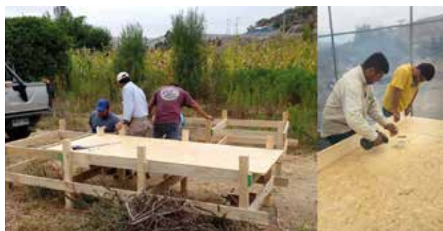
Figura 4. Instalación de plancha estructural OSB y tapa lateral.
