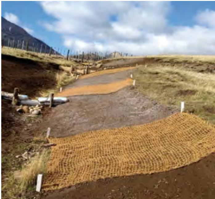
Figura 8. Cárcava con diques de protección en el centro y sistemas de protección de laderas para permitir su revegetación.
