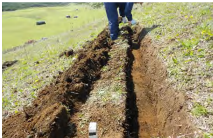
Figura 7. Construcción de zanja de infiltración en sector de ladera.
