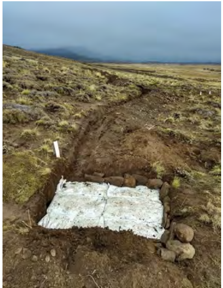
Figura 9. Canal de desviación y zona de amortiguación construida con sacos rellenos de tierra.
