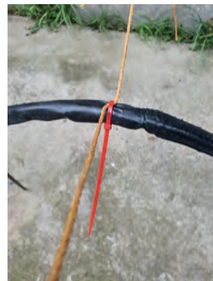
Figura 7. Sujeción de la soga o lienza a cada arco.
