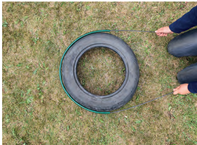
Figura 4. Moldear el fierro de construcción con la ayuda de un neumático.
