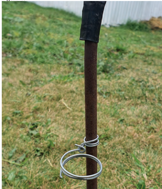
Figura 6. Ojal instalado en la base del arco.
