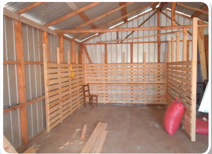
Foto 4. Detalle como se fijan las paredes a la estructura de la bodega
