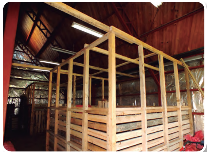
Foto 8. Detalle cómo se refuerza la estructura
