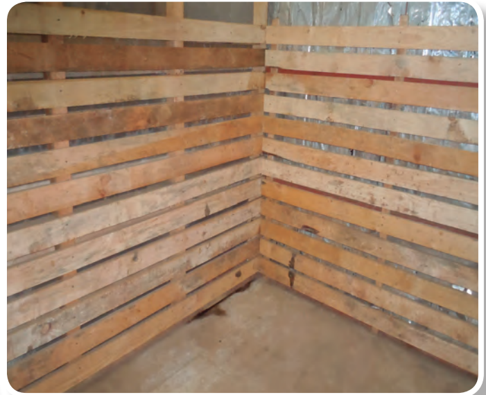
Foto 3. Detalle como se unen las paredes troja
