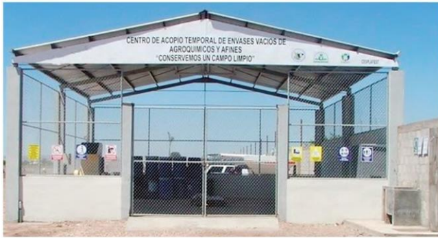
Figura 2. Centro de acopio de envases vacíos de plaguicidas.
