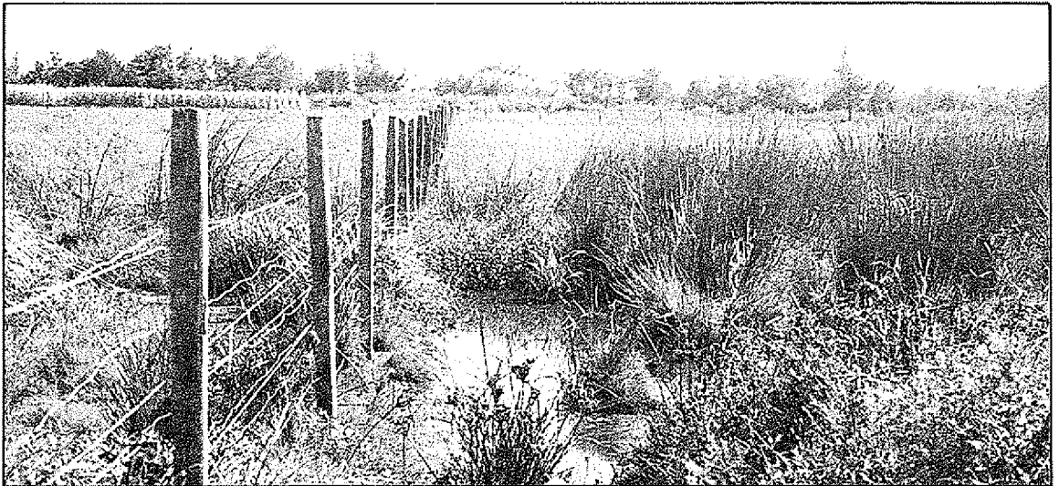
Nivel freático visible y excesiva presencia de malezas (suelo regado Mañil).
