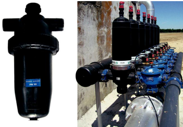
Figura 6. Filtro de anillas de operación manual (izq) y con retrolavado automático (der)
