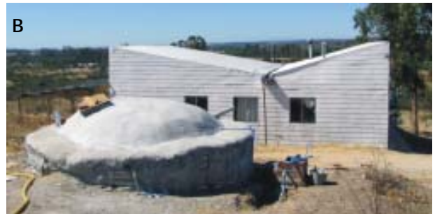
Foto 4. Cisternas de concreto y fierro (ferrocemento). Estructuras adecuadas para almacenamiento de volúmenes de: (A) 10.000 y (B), 15.000 litros de agua. Proyecto FIC-R O'Higgins. Comuna de Litueche, Año 2012.
