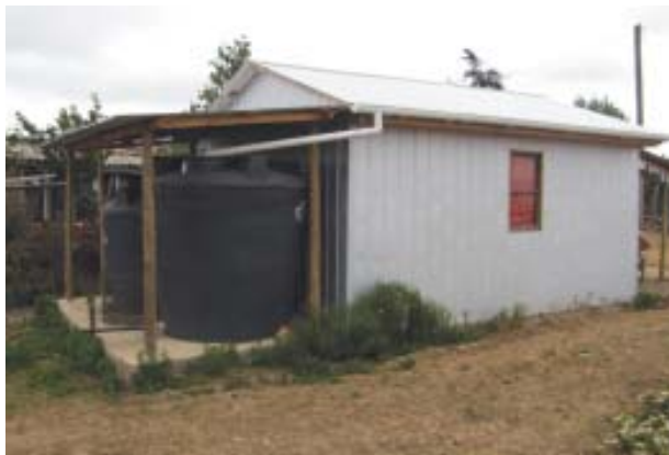
Foto 3. Sistemas de cosecha y acumulación de aguas lluvias utilizando techos de las casas y estanques acumuladores. Prodesal de Navidad. La Aguada, Comuna de Navidad.
