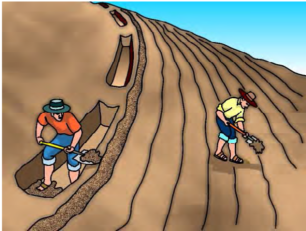
Figura 4. Realizando el mantenimiento de la zanja de infiltración.
