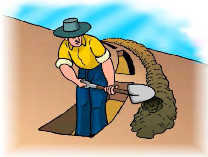
Figura 3. Depositando la tierra en la parte baja de la zanja, a unos 30 centímetros de distancia del borde de la zanja.
