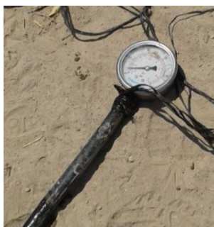
Fotografía 3. Manómetro instalado en lateral.
