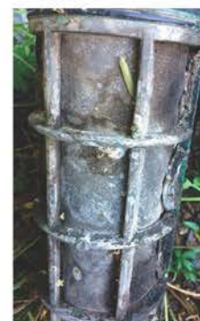
Figura 5: Filtro de malla saturado de sedimentos producto de aplicación de extracto húmico sin realizar limpiezas correspondientes.
