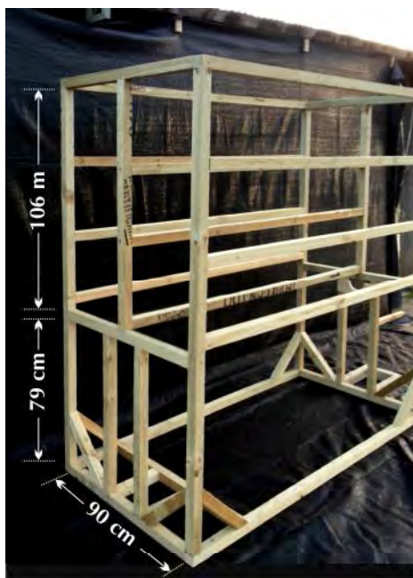
Figura 3. Vista lateral de la estructura, con pilares cortos para fijar el estanque y las repisas horizontales.
