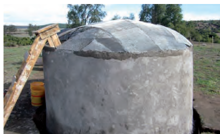
Foto 4. Revestimiento de la cubierta con malla "acma" y malla de "harnero".
