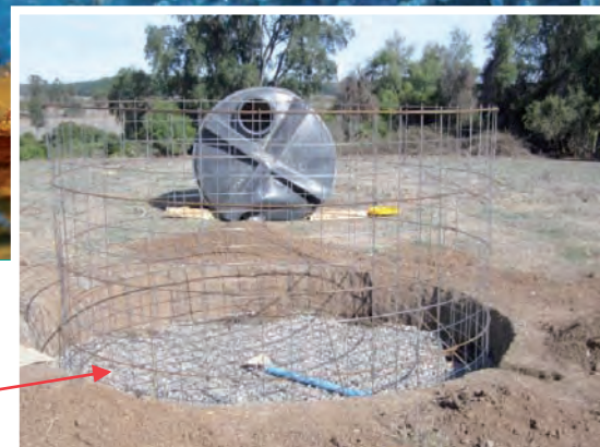
Foto 2. Esqueleto de la cisterna que brindará mayor firmeza a la estructura.
