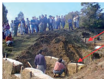
Foto 1. Uso de "lampazos" y fardos para el control de cárcavas. Comuna de Pichilemu, Región de O'Higgins.
