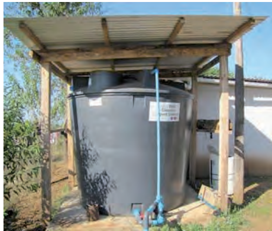
Foto 1. Proyecto tipo de un sistema de cosecha y acumulación de aguas lluvias utilizando techos de las casas y estanques acumuladores. Comuna de La Estrella, Región de O'Higgins.
