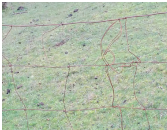
Foto 1. Cerco en mal estado.
