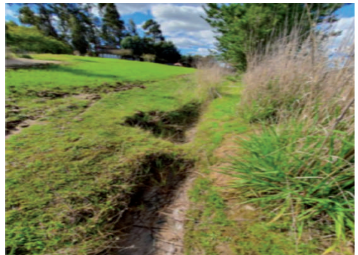
Foto 1. Saltillos en el canal de desagüe para reducir velocidad y fuerza del agua.
