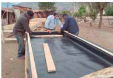
Foto 3. Colocación de lámina HDPE.
