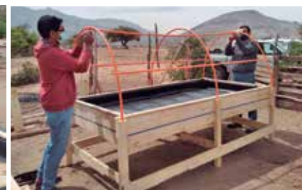
Foto 4. Instalación tubos conduit.
