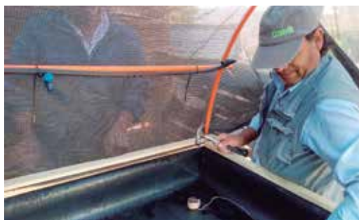
Foto 5. Instalación malla raschel.
