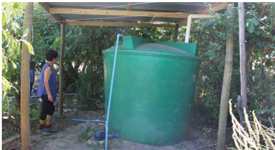
Foto 3. Unidad de sistema de cosecha y acumulación de aguas lluvias modelo INIA instalado en la comuna de Pumanque.
