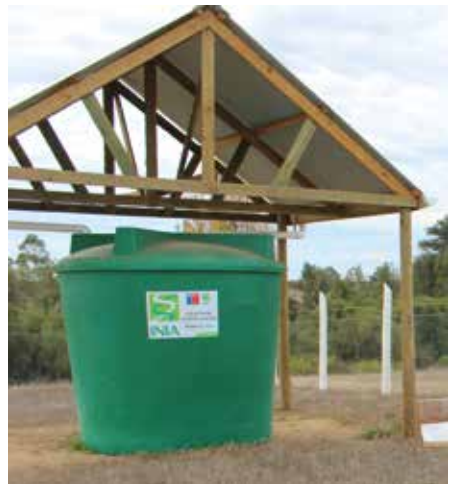
Foto 1. Unidad tipo de un sistema de cosecha y acumulación de aguas lluvias modelo INIA utilizando techos de las casas, y estanque acumulador bajo un cobertizo.
