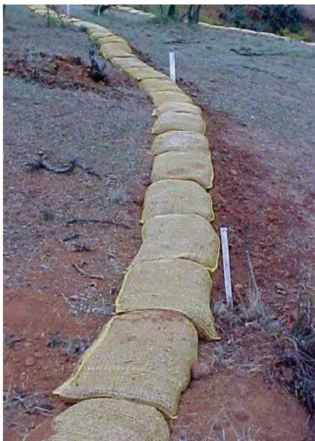
Figura 1. Sacos de malla tejida llenos con suelo y semillas de especies herbáceas ubicadas en los bordes de la cárcava. Comuna de Pichilemu, región de O'Higgins.
