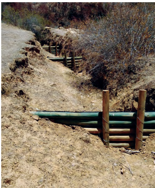
Figura 2. Uso de postes impregnados al interior de una cárcava. Peñablanca, comuna de Pumanque, región de O'Higgins.
