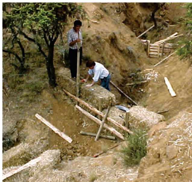
Figura 3. Uso de fardos de paja para el control de cárcavas. Comuna de Pichilemu, región de O'Higgins.
