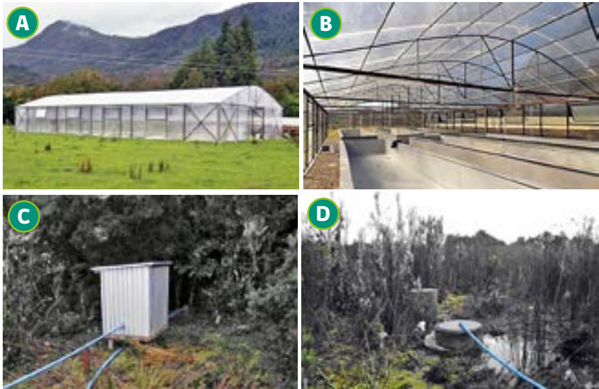
Fig. 3. Infraestructura generada para el proceso de masificación artificial. A) Invernadero recubierto en policarbonato, B) Contenedores de fibra de vidrio, C) Caseta motobomba sistema hidráulico y D) Acumulador de agua en la turbera.
