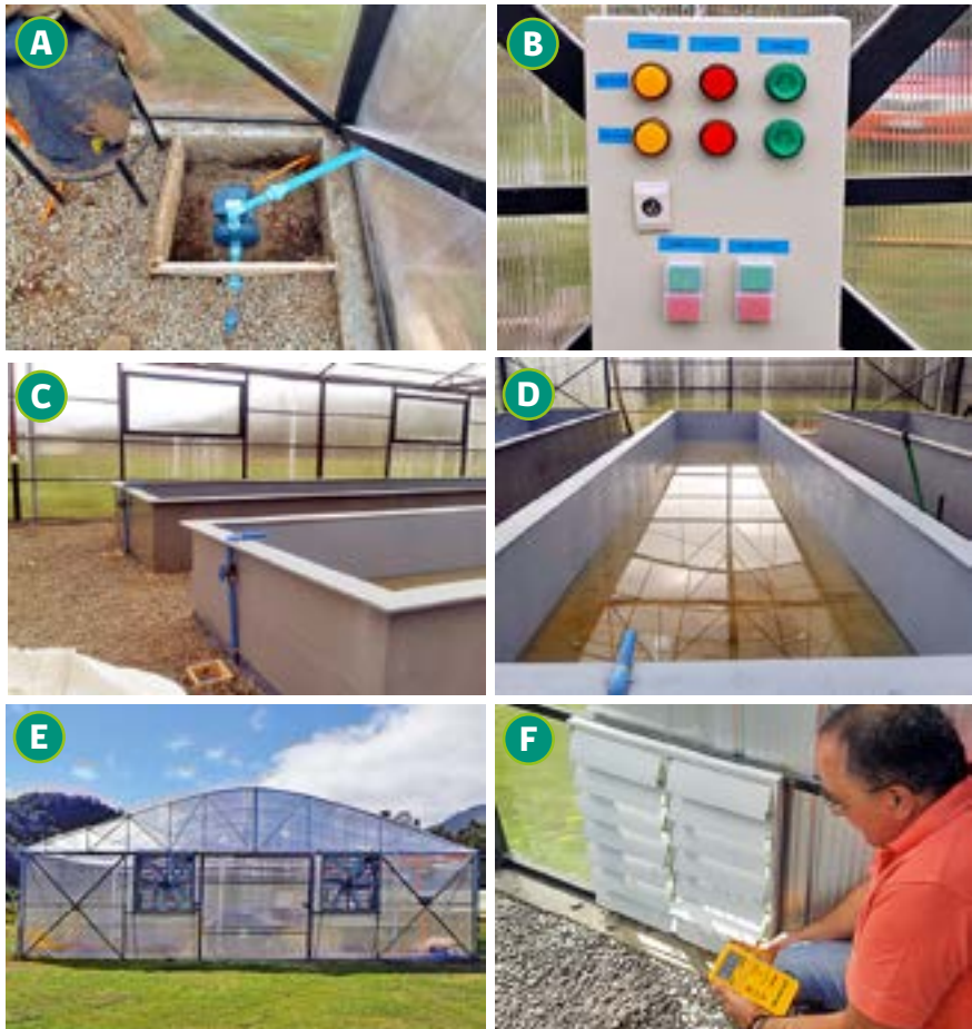
Fig. 4. Sistema hidráulico dispuesto en el interior del invernadero. A) Motobomba de extracción de agua desde contenedores, B) Tablero de control, C) Llaves de paso dispuestas en cada contenedor, D) Incorporación de agua a contenedores, E) Extractores de aire industriales y F) Persianas sincronizadas a extractores para la circulación del aire.
