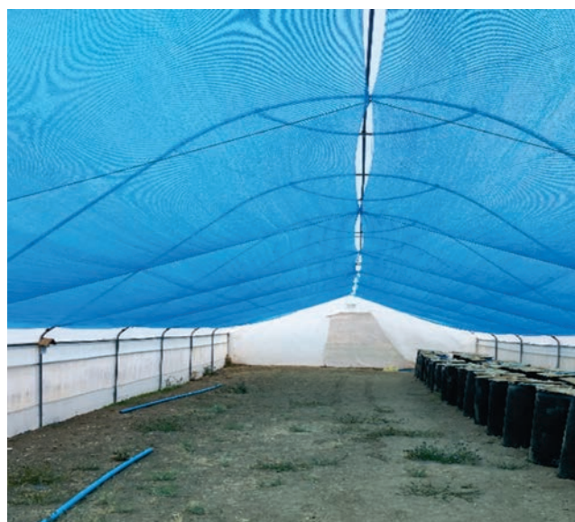
Figura 6. Uso de malla raschel azul en invernadero ubicado en la localidad Chapiquiña (3.287 msnm). Fuente. INIA, 2020.
