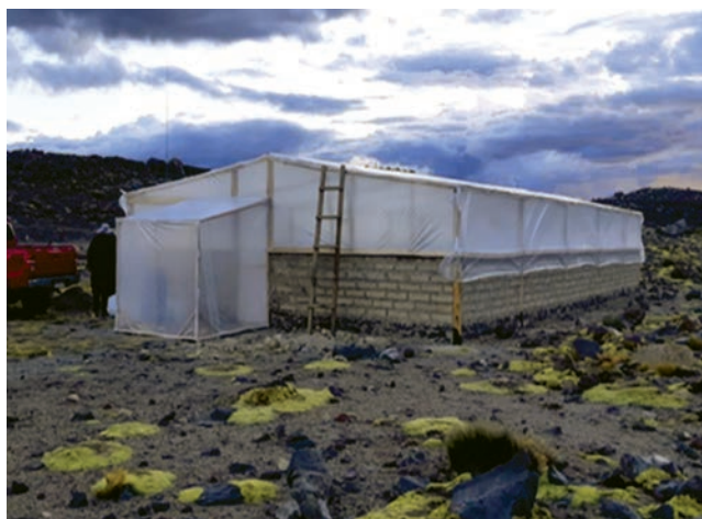
Figura 2. Invernadero ubicado en la localidad de Parinacota a 4.412 msnm (Fuente. INIA, 2019).
