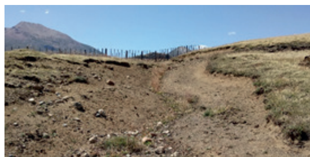
Figura 1: Cárcava activa, Villa Ortega, región de Aysén
