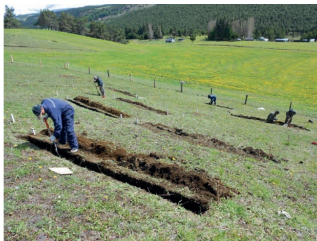
Figura 1: Zanjas de infiltración construidas en curvas de nivel, Cuesta Alvarado, región de Aysén
