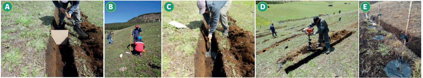
Figura 2 A: Zajas de infiltración de 0,3 m base, 0,3 m altura y 0,4 m abertura superior. B: Determinación de curvas de nivel en terreno, para construcción de las microterrazas. C: Construcción de zanjas de infiltración y acumulación de suelo pendiente abajo. D: Ahoyadura para la plantación de arbustos y árboles. E: Plantas de lengas con cubierta antimalezas y entutorado en zanjas
