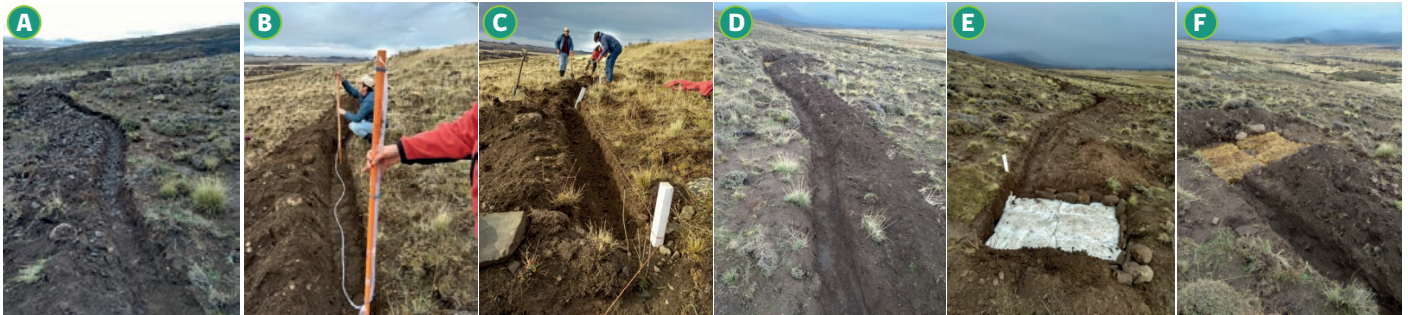
Figura 2 A: Canal de desviación construido siguiendo las curvas de nivel. B Determinación de curvas de nivel en terreno, para construcción del canal de desviación. C: Estacada para marcar el trazado del canal de desviación. D: Acumulación de material pendiente abajo del canal de desviación. E: Zona de descarga construida con sacos rellenos de tierra. F: Zona de descarga construida con fardos de paja.
