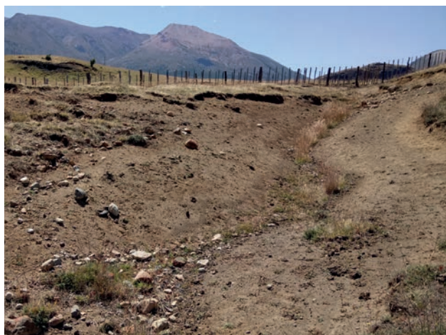
Figura 1: Cárcava en terreno producto de erosión hídrica por escurrimiento superficial, Villa Ortega, región de Aysén.
