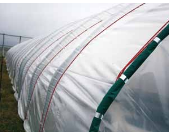
Figura 19. Cubierta instalada y tensa.
