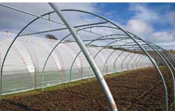
Figura 18. Instalación de larguero.
