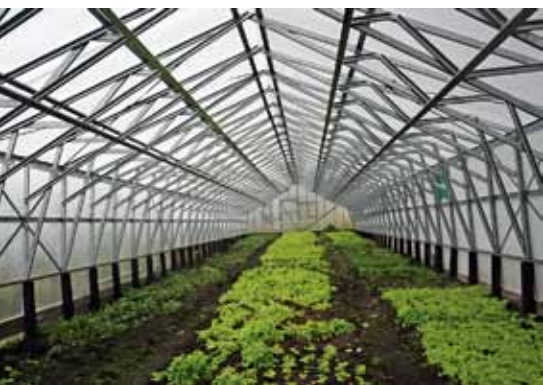
Figura 11. Invernadero metálico a dos aguas.
