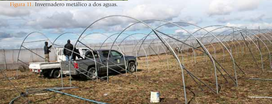
Figura 11. Invernadero metálico a dos aguas.
