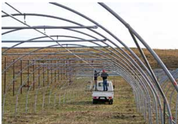
Figura 16. Refuerzo de diagonales.
