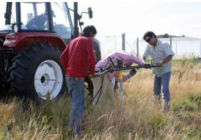
Figura 14. Instalación de anclas.
