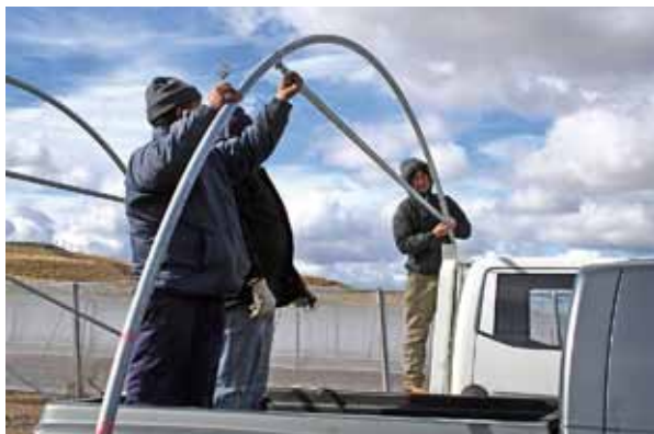
Figura 17. Instalación de travesaños.
