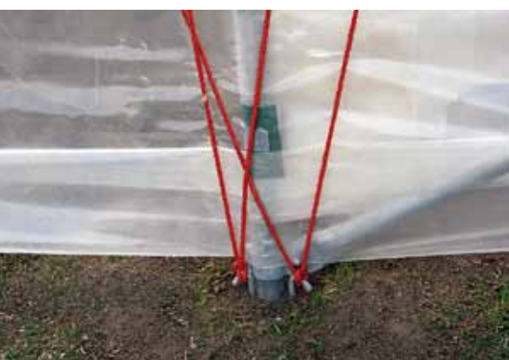
Figura 20. Tensado de la cubierta mediante cuerdas.
