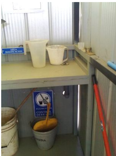
Foto 6. Sala de dosificación tipo.
