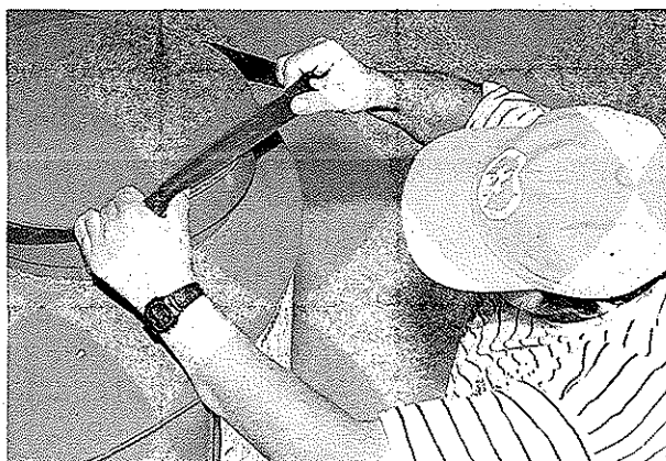
Foto 3. Cuando se fumiga el grano, el silo debe ser sellado herméticamente en la boca de entrada y de salida, con una tira de cámara de neumático.
