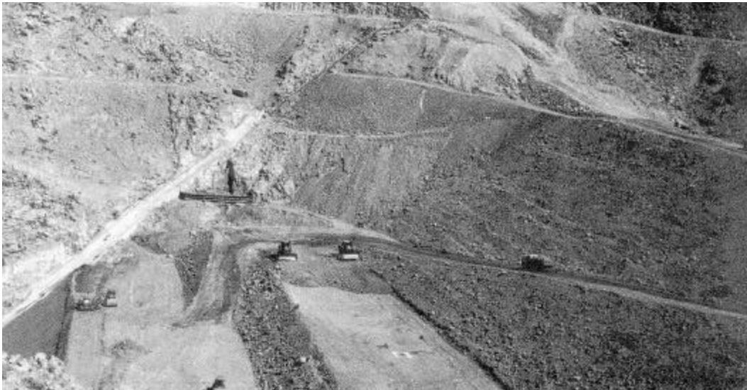
Foto 1. Cortina Embalse Santa Juana en construcción. Vallenar, III Región.
