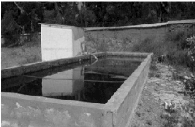
Foto 2. Estanque de hormigón
