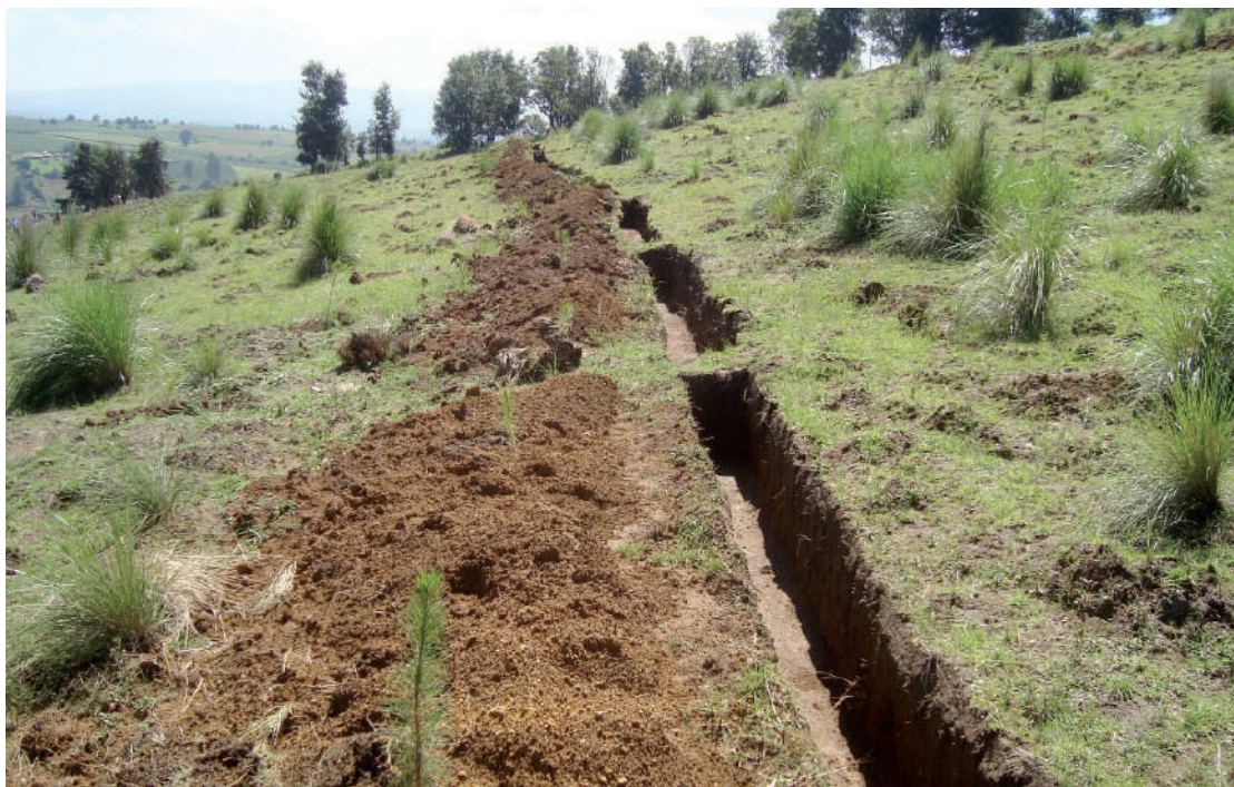
Figura 4. Ejemplo de zanjas de infiltración.
