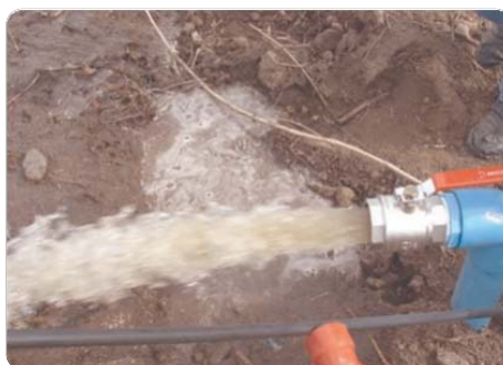
Fotografía 3: Lavado de la red de riego con eliminación del agua y sólidos en suspensión.
