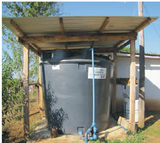
Foto 1. Proyecto tipo de un sistema de cosecha y acumulación de aguas lluvias utilizando techos de las casas y estanques acumuladores. Comuna de La Estrella, Región de O'Higgins.
