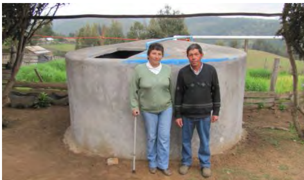
Figura 15. Cisternas de concreto y fierro (ferrocemento). Estructuras adecuadas para almacenamiento de volúmenes de 10.000 litros de agua. Comuna de Pichilemu, Región de O'Higgins.
