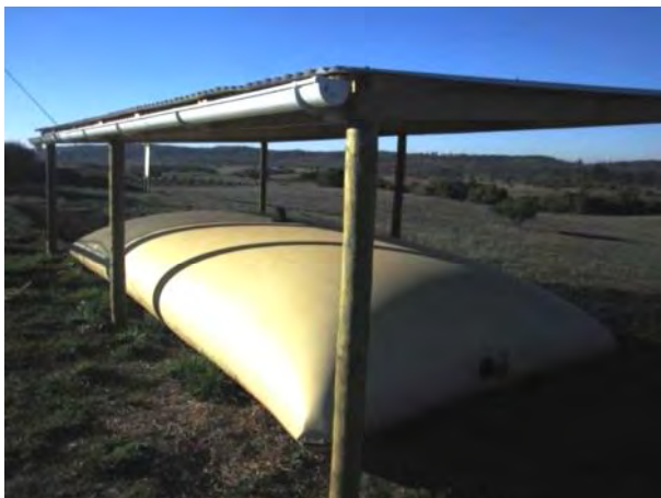
Figura 14. Cisterna flexible con capacidad de acumulación de 10.000 litros de agua, con techo protector. Comuna de Litueche, Región de O'Higgins.
