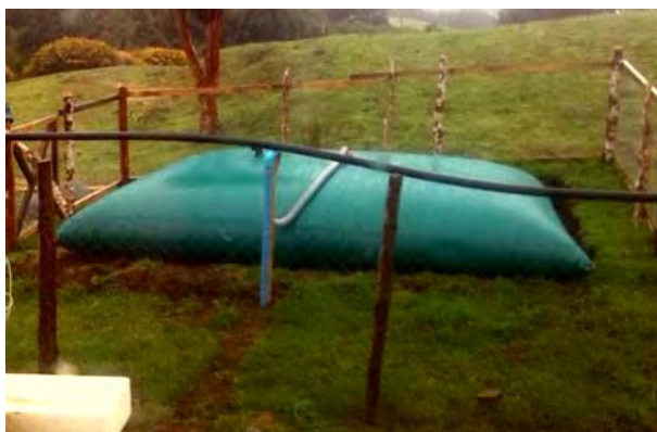
Figura 13. Cisterna flexible con capacidad de acumulación de 10.000 litros de agua. Comuna de Ancud, Región de Los Lagos. Proyecto INIA-CNR.
