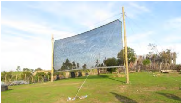
Figura 18. Sistema “atrapanieblas” y de aguas lluvias, de 40 m 2 de superficie de captación. La Aguada, comuna de Navidad. Región de O’Higgins.
