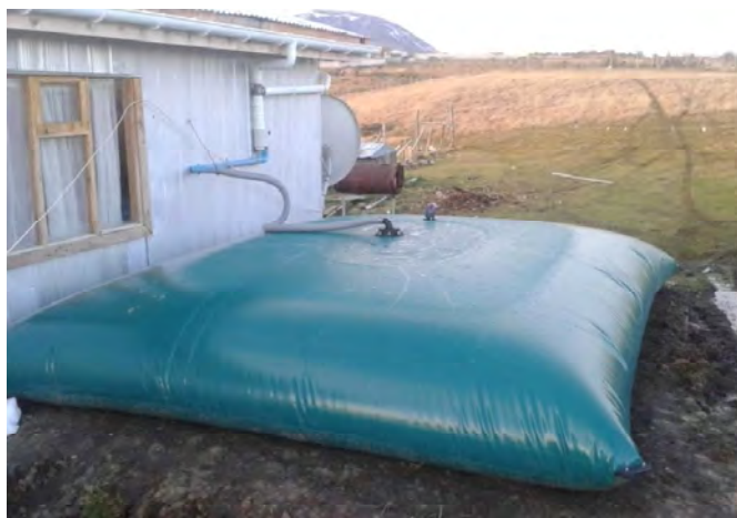
Figura 13. Cisterna flexible a máxima capacidad con sistema de colecta de aguas lluvias. Comuna de Natales, Región de Magallanes y la Antártica chilena. Proyecto de desarrollo convenio INIA-CNR.
