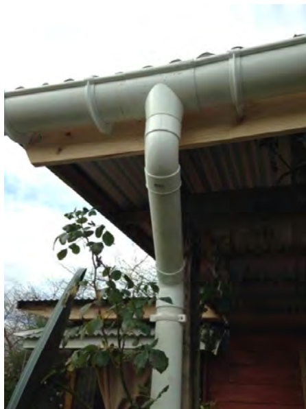
Figura 5. Ganchos de sujeción ubicados al costado de la bajada de agua.
