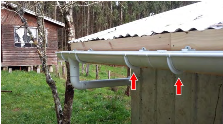
Figura 4. Ganchos de sujeción ubicados a 15 cm desde la unión de las dos canaletas.
