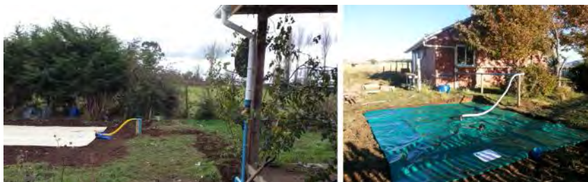
Figura 11. Izquierda: Instalación de cisterna flexible con entrada lateral y filtro de bronce. Derecha: Instalación de cisterna flexible con entrada superior y filtro de polietileno.
