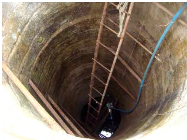
Figura 7. Pozo noria revestido con tubos de hormigón.
