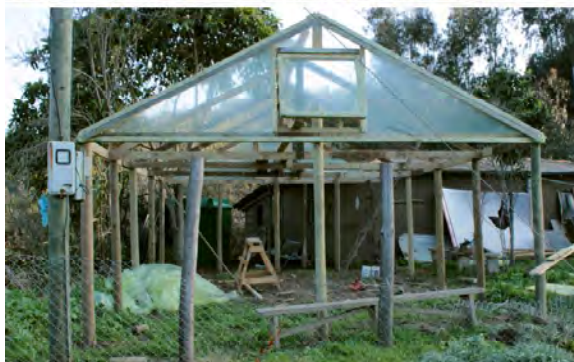
Figura 10. Detalle del montaje de la cercha frontal.
