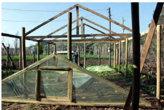
Figura 9. Detalle de la cercha frontal con la ventana de ventilación previamente instalada.
