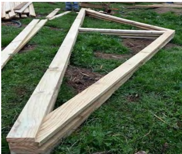
Figura 5. Construcción de cerchas centrales.
