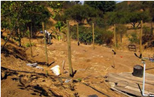
Figura 3. Ubicación de postes, para un invernadero de 40 m 2 .
