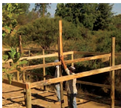
Foto 2. Colocación de tablas de pino para dar la altura central deseada.
