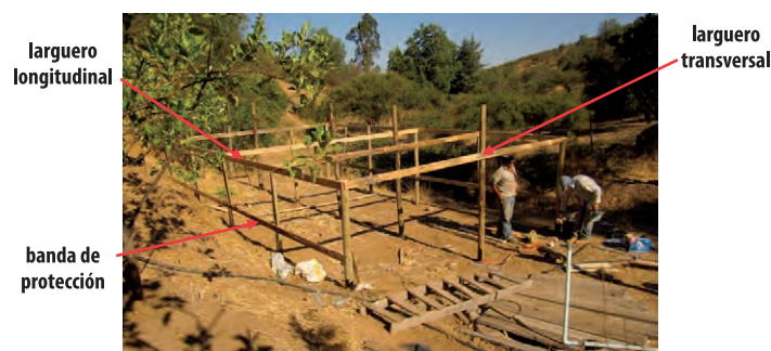
Foto 1. Colocación de largueros.
