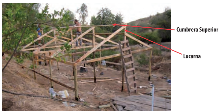
Foto 3. Colocación de vigas y cumbres.
