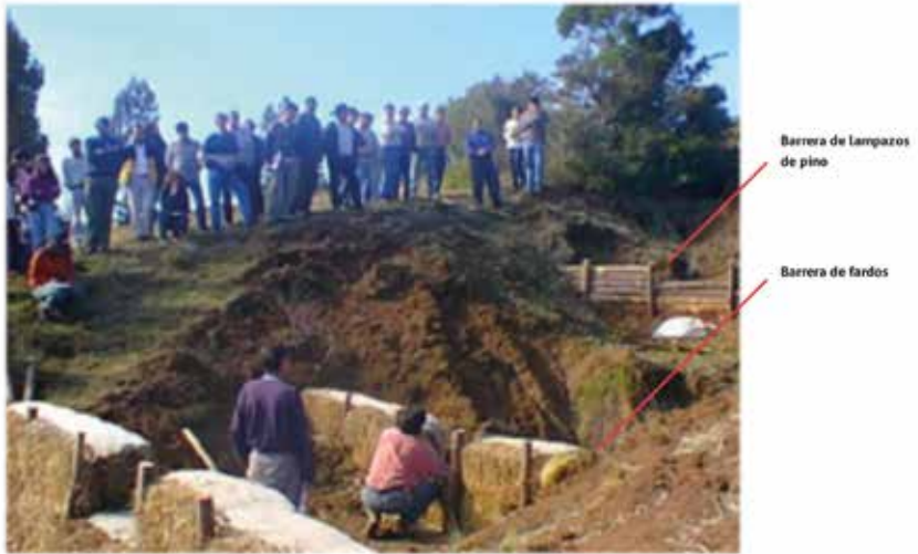
Figura 3. Uso de "lampazos" y fardos para el control de cárcavas. Comuna de Pichilemu, Región de O'Higgins.
