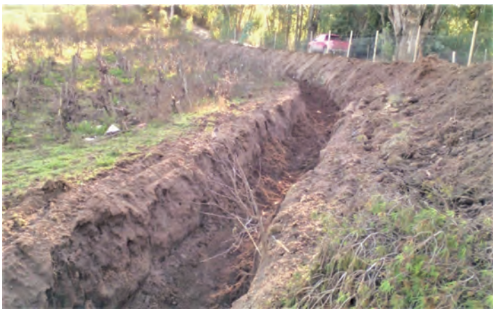
Foto 6.8. Dren abierto para evacuar excesos de aguas lluvias. Comuna de San Nicolás.
