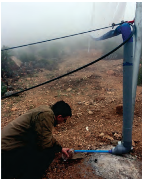
Figura 4.3. Atrapanieblas, como fuente de abastecimiento de agua para el regadío de olivos en Taltal.
