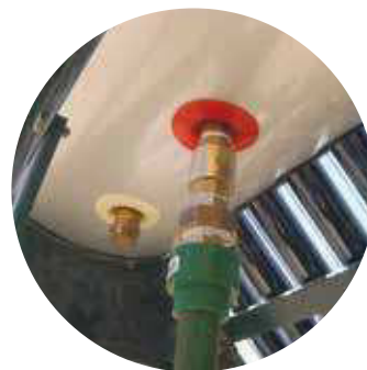
► (a) Sistema termosolar con tubos de vacío (Heat Pipe). (b) Detalle de la salida de agua caliente desde el estanque.
