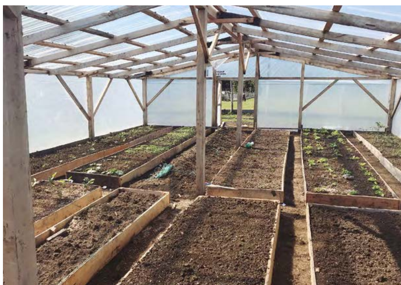
📍 Figura 1. Invernadero en Chaitén.
