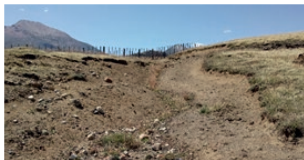
Figura 1: Cárcava activa, Villa Ortega, región de Aysén
