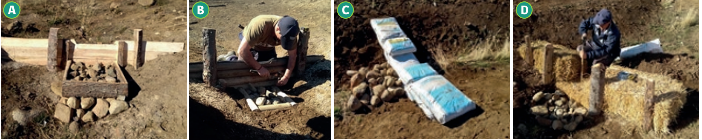
Figura 2 A: Dique construido con tapas de lenga y cajones de descarga posterior. B: Dique construido con polines de pino impregnado. C: Dique construido con sacos rellenos de tierra. D: Dique construido con fardos de paja.
